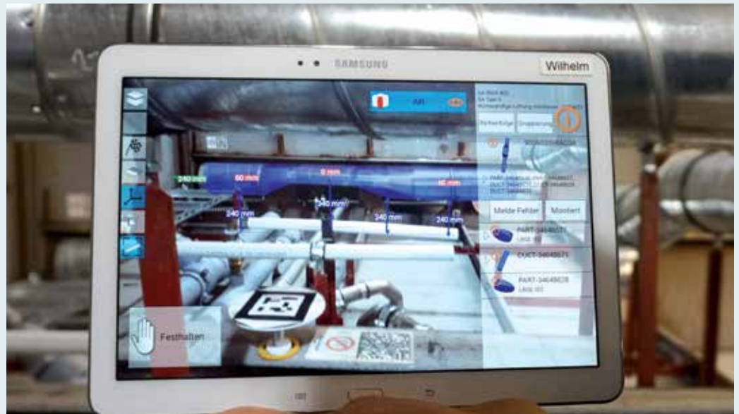
Einsatz der digitalen Arbeitsunterlage zur Ausrichtung von Rohren und Haltern
